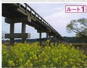
ルート1 蓬莱橋 全長897.4メートルの世界一の長さを誇る木造歩道橋。現在も農道として利用されている。
